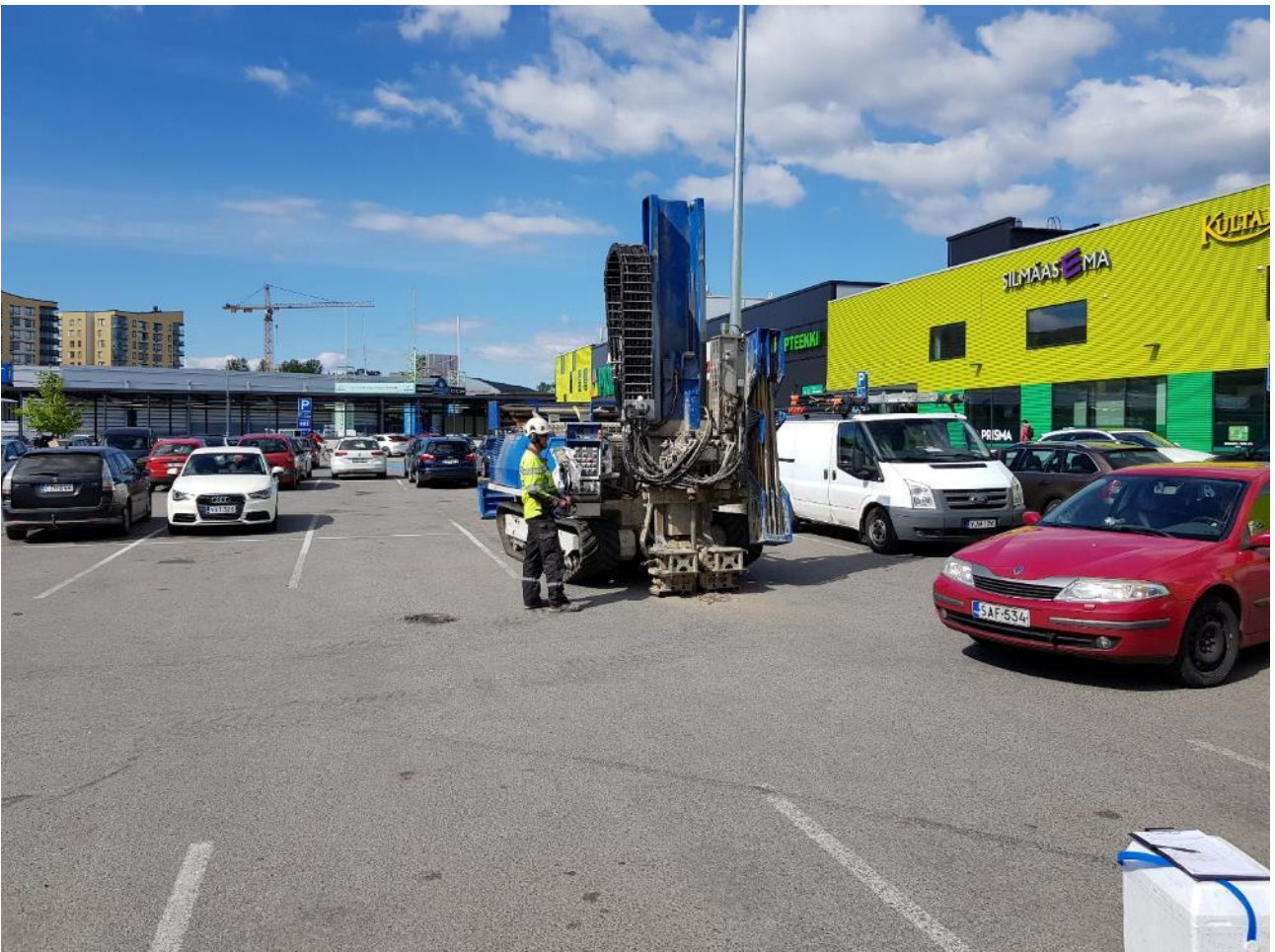
Kuva 10. Kairausnäytteenotto pisteen RKP12 kohdalla 1.6.2021.
