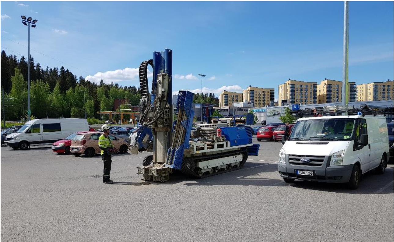
Kuva 11. Kairausnäytteenotto pisteen RKP31 kohdalla 1.6.2021.
